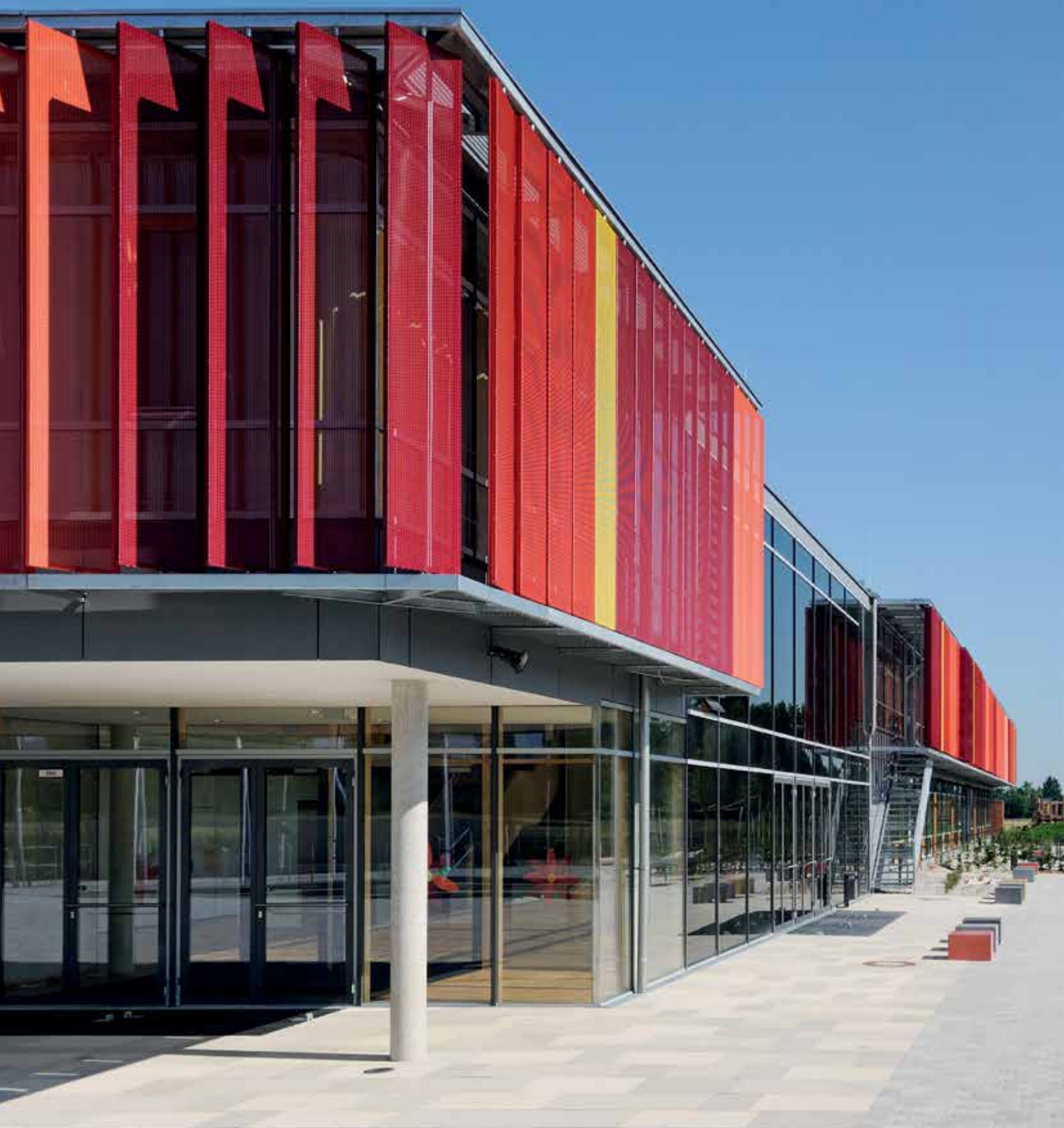
Grundschule – Neubiberg, DE
