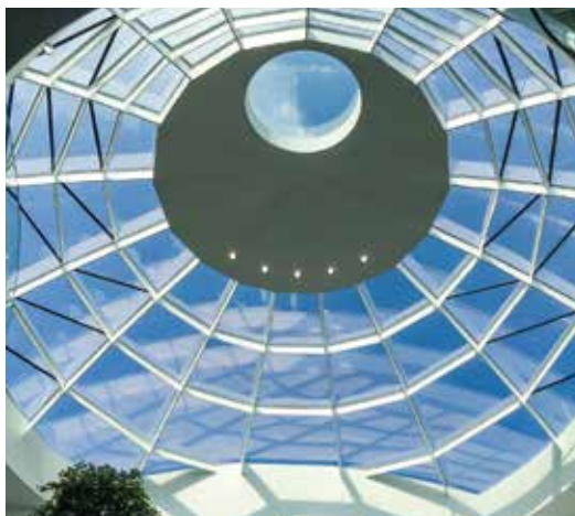
Bürogebäude – Bad Sankt Leonhard, AT
