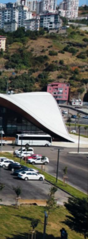
Das patentierte BEMO-MONRO-System steht für die flexible Anpassungsfähigkeit von Metalleindeckungen an nahezu jede Gebäude-Geometrie. Dabei ist häufig jede einzelne Bahn eines Freiform-Gebäudes ein Unikat. Die Metallbahnen werden – auf Basis exakter 3D-Aufmaß-Daten – in einem Arbeitsschritt millimetergenau für den bemessenen Platz am Gebäude geformt.
