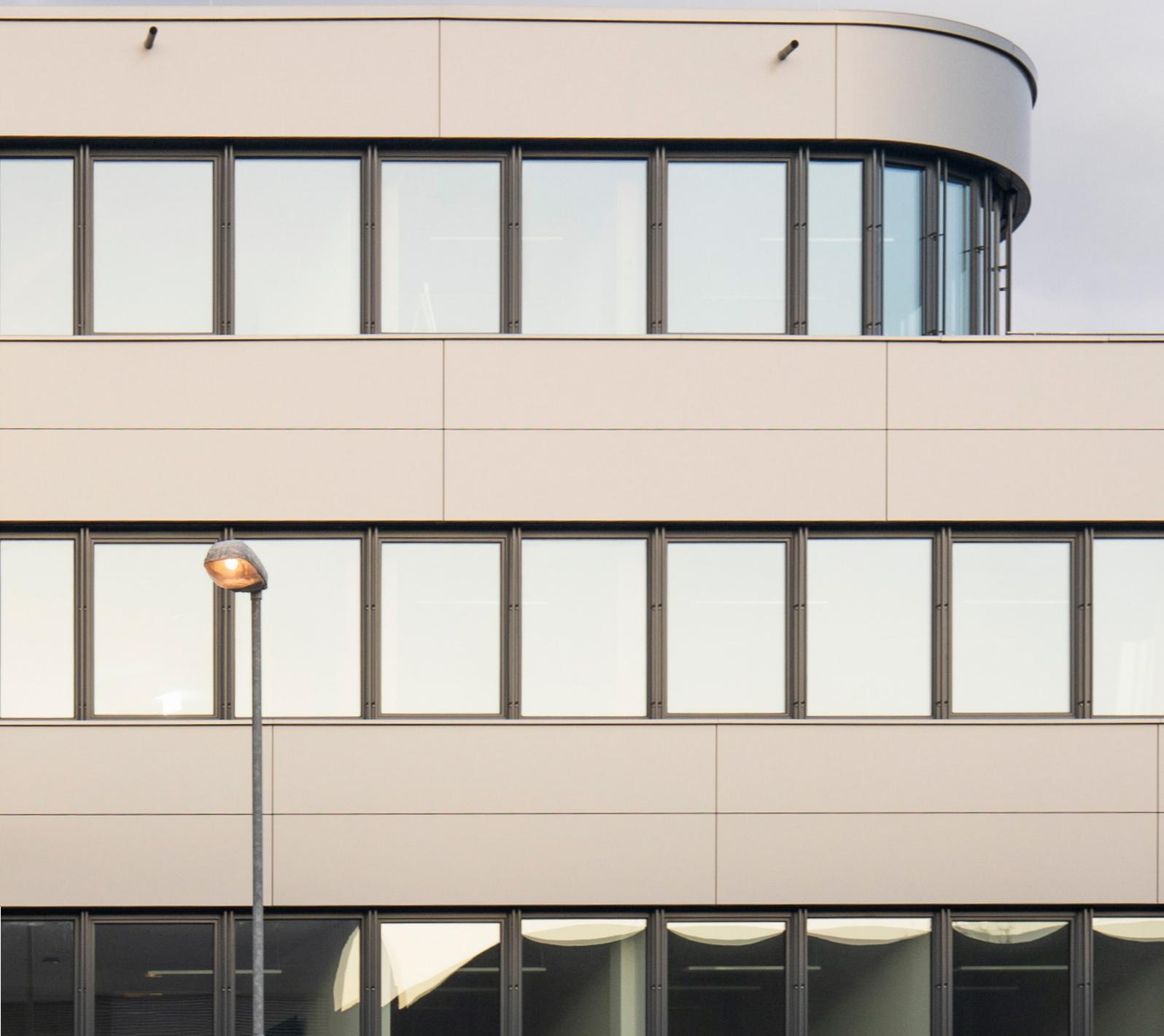
Die Aluminium-Verbundplatten BEMO-BOND A2 bestehen aus zwei 0,5 mm dicken Aluminium-Deckblechen, die in einem Schmelzfixierverfahren auf einen nicht brennbaren mineralischen Kern aufgetragen werden. Sie können bis zu einer Breite von 2 m geliefert werden, was weltweit einzigartig ist.
