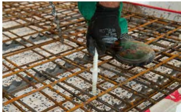
Schöck Isolink® Typ TA-HC in die vorgebohrte Wärmedämmschicht einstecken.
