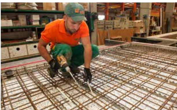
Gegebenenfalls Diagonalstäbe einsetzen (Schöck Isolink® Typ TA-DC).
