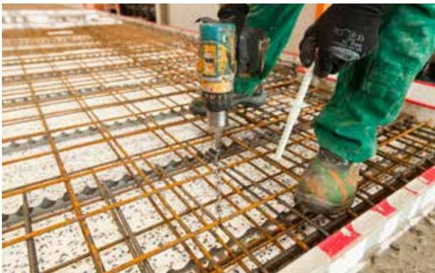
Löcher in Dämmung vorbohren.
