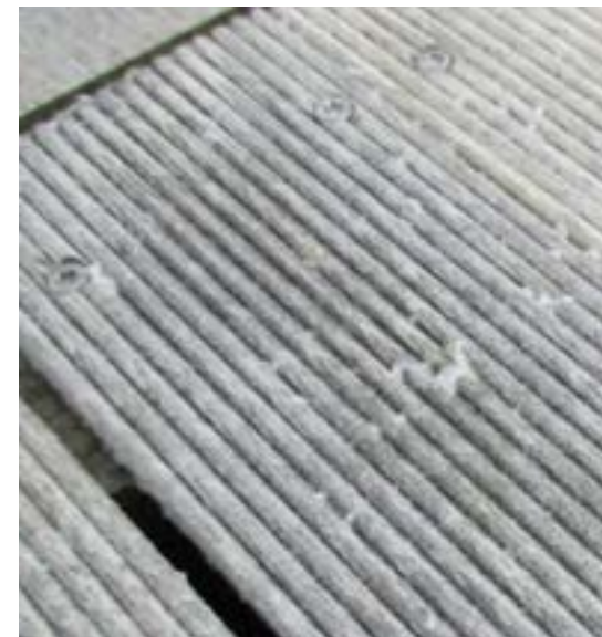
8.4 Fasern können sich in gerippten Oberflächenprofilen verfangen
