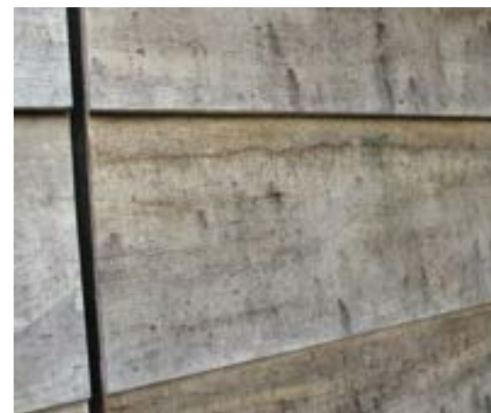
Raue gesägte Oberflächen sind der Aufbauschicht zuträglicher
