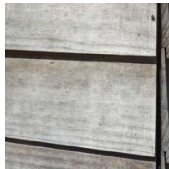
Raue gesägte Oberflächen sind der Aufbauschicht zuträglicher
