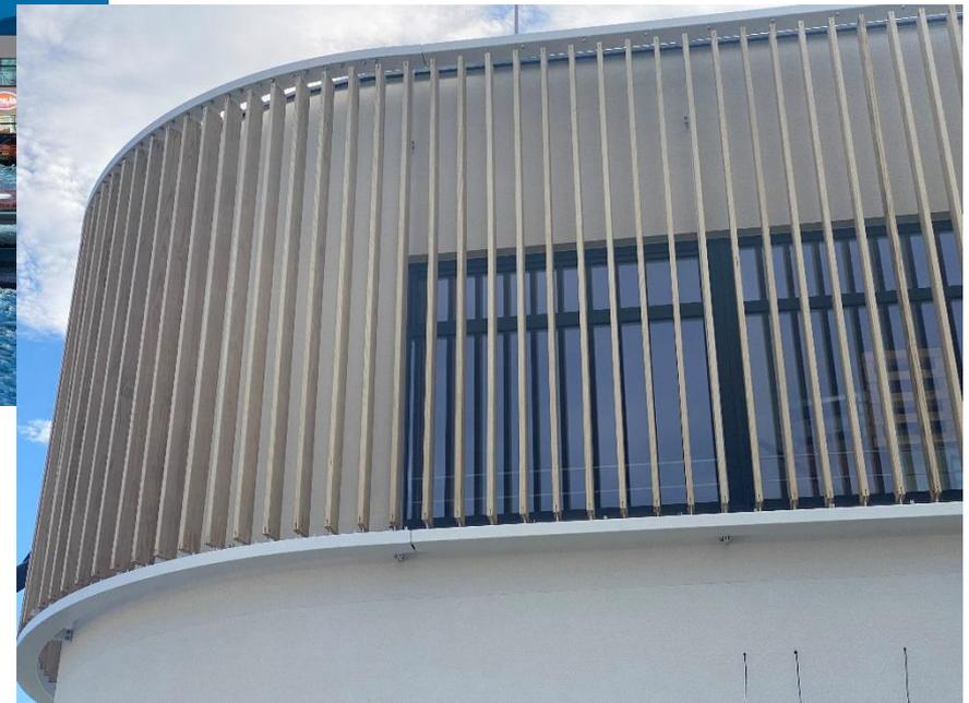
Vertikale Lamellenfassade 41x190mm
