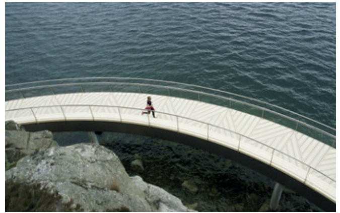
Brücke in Norwegen
