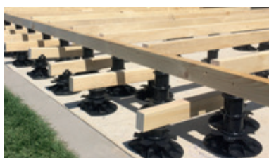
Unterkonstruktion Aus Holz und Alu sowie Terrassenfüße
